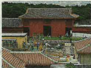
再建作業が進む首里城の正殿跡(中央) =2020年6月、那覇市
